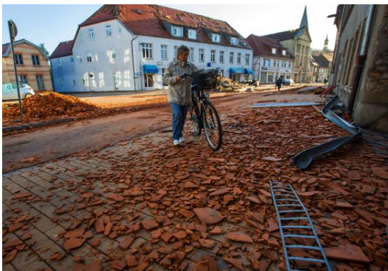
Mai 2015 / Tornadoschäden in Bützow (dpa)
